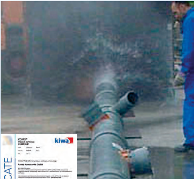
Montage de l'essai hydrocurage
