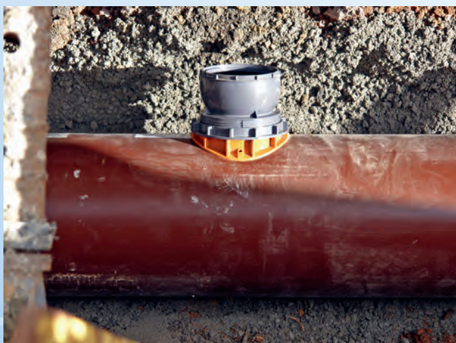
Raccord de piquage CONNEX sur tube HSK en PVC-U tricouche compact CR 12
