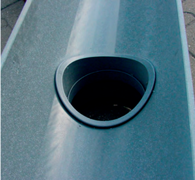
Vue intérieure après hydrocurage
